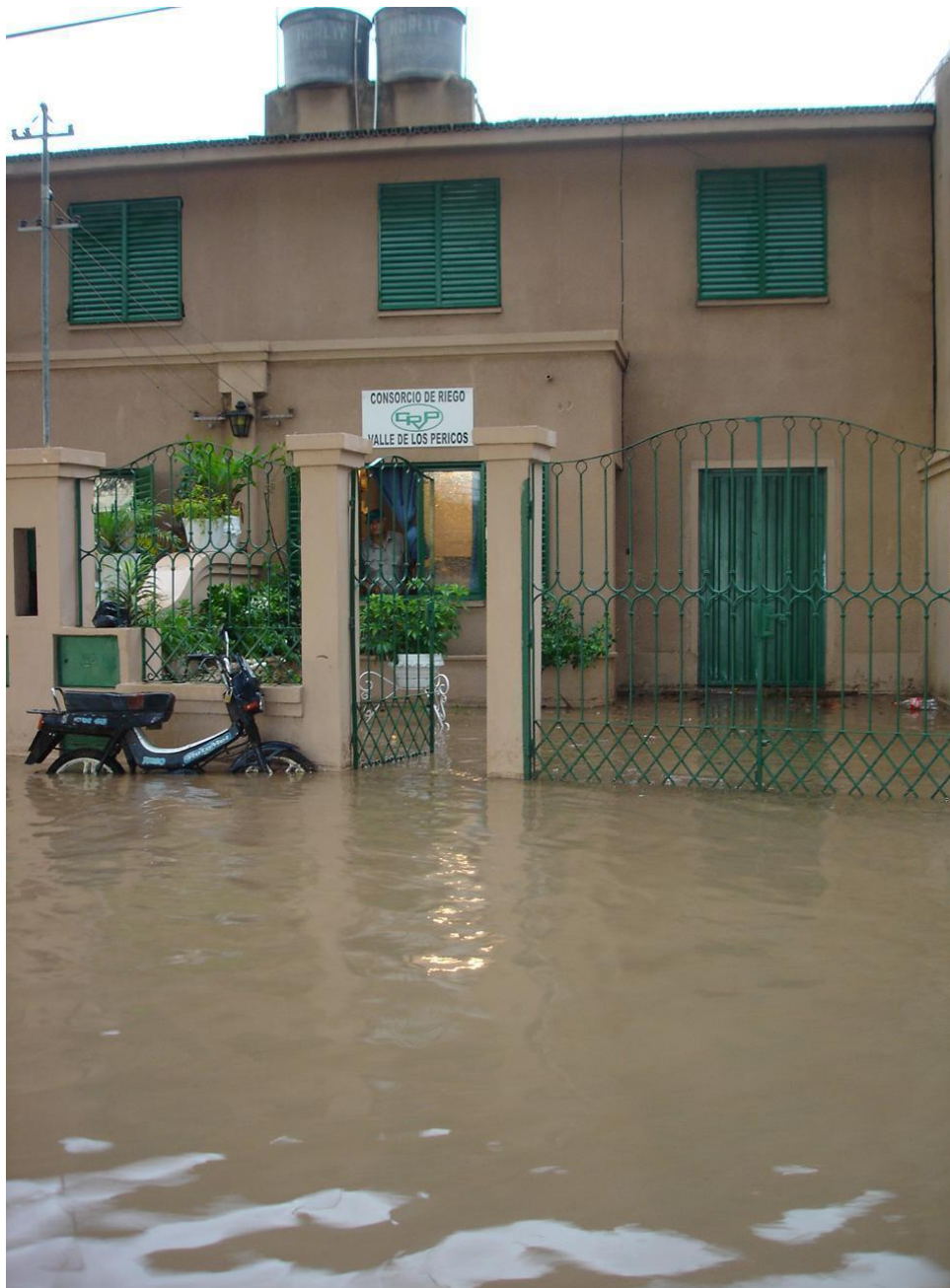
Figura 5: Ingreso de agua en instalaciones del Consorcio de Riego Valle de Los Pericos
