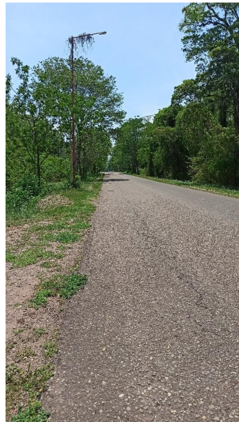
Fotografía 13. Camino de acceso a Caimancito, vista hacia el Oeste
